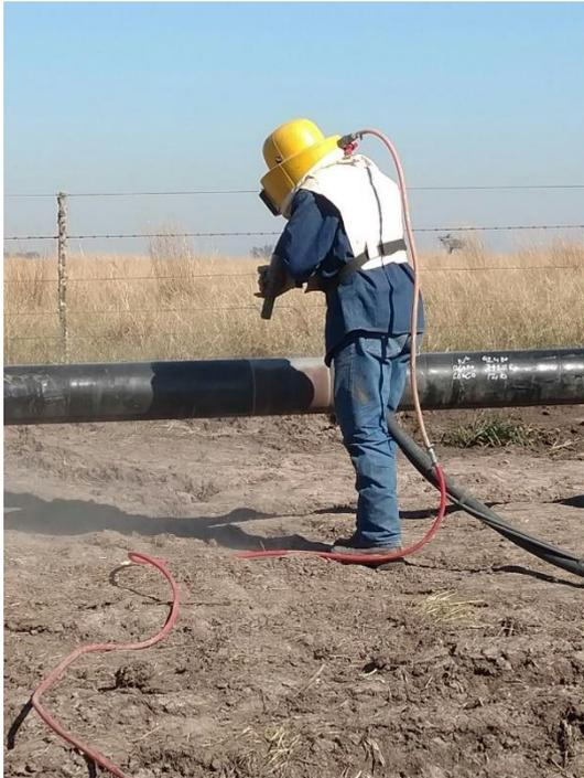
Fotografía 2. Operario realizando tareas de arenado
