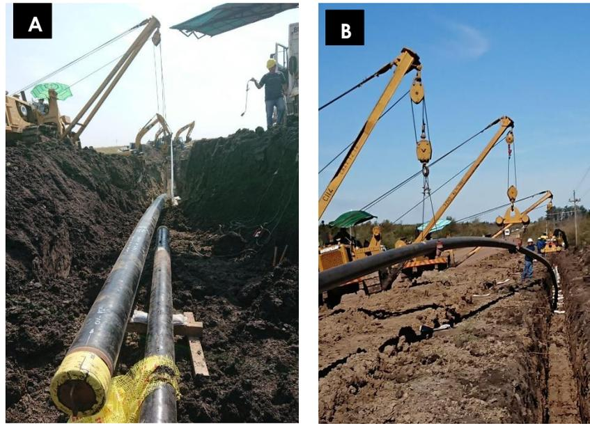
Figura 4 A y B. Bajada de cañería, presencia de almohadillas y separación del top soil
