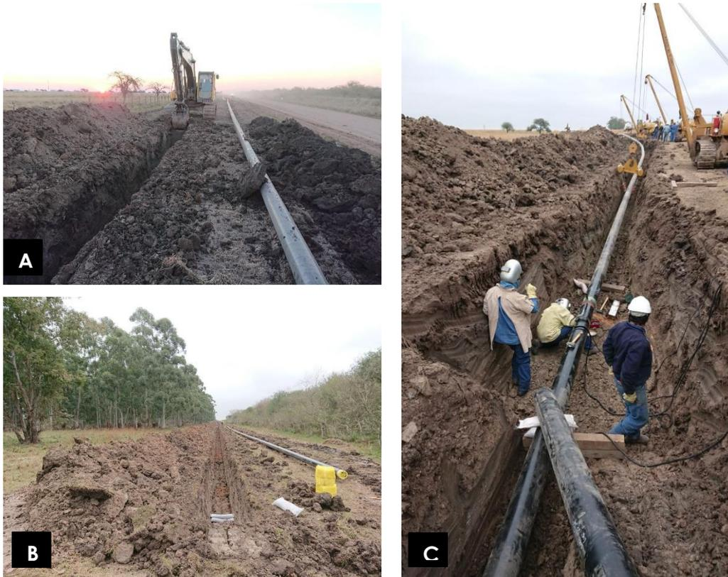
Figura 3 A, B y C. Excavación y separación del top soil en diferentes puntos de la línea
