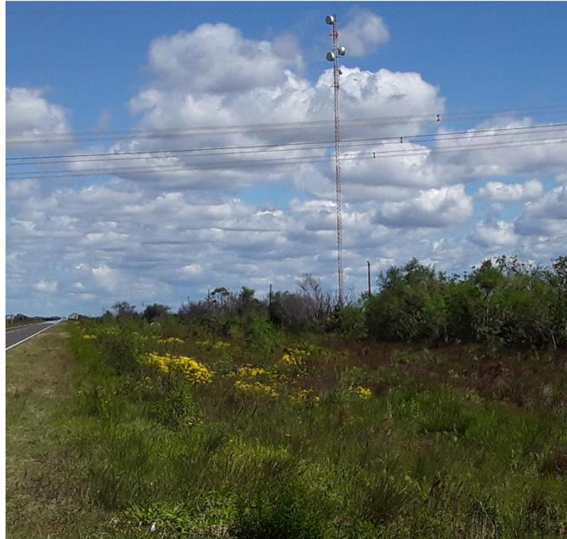
Vista Antena de radio enlace usadas para el telemando de los electroductos de 500 kV
